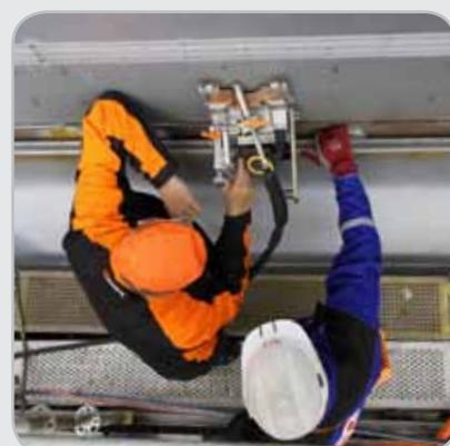
Настройку выполнить несложно, а все регулировки параметров сварки выполняются на тракторе, что сокращает время настройки и облегчает дистанционное управление.
